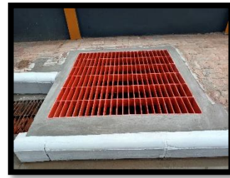
๑๐.โครงการก่อสร้างรางระบายน้ำพร้อมฝาดะแกรงเหล็กถนข้าง อบต.เขาไม้แก้ว หมู่ที่ ๑
