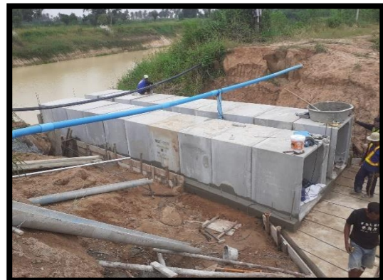
๑๓.โครงการโครงการก่อสร้างท่อลอดเหลี่ยมคอนกรีตเสริมเหล็ก บริเวณอ่างเก็บน้ำหมู่ที่ ๒
