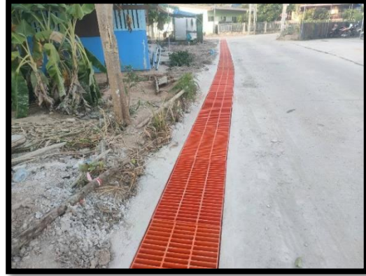
๑๒. โครงการก่อสร้างรางระบายน้ำสายมาบเจริญ หมู่ที่ ๒ (กำลังดำเนินการ)
