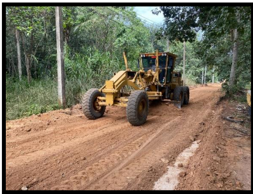
๙.โครงการก่อสร้างถนนคสล.สายฮวงซู่ หมู่ที่ ๕
