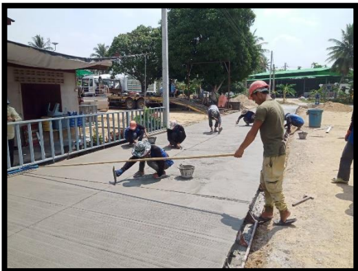
๖.โครงการก่อสร้างถนน คสล.สายบ้านนายเซวี่ หมู่ที่ ๓
